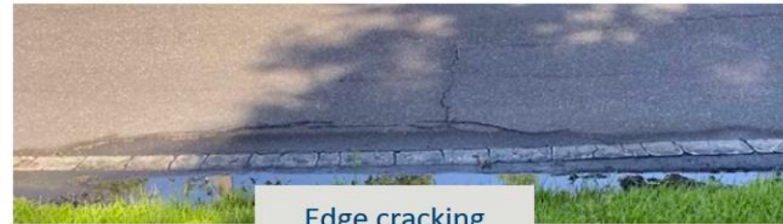
Edge cracking
